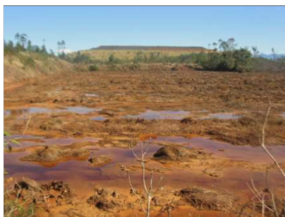
Figura 6 - Vista parcial das antigas instalações do wetland da Unidade Mineira Verdinho, com o depósito de rejeito ao fundo.
