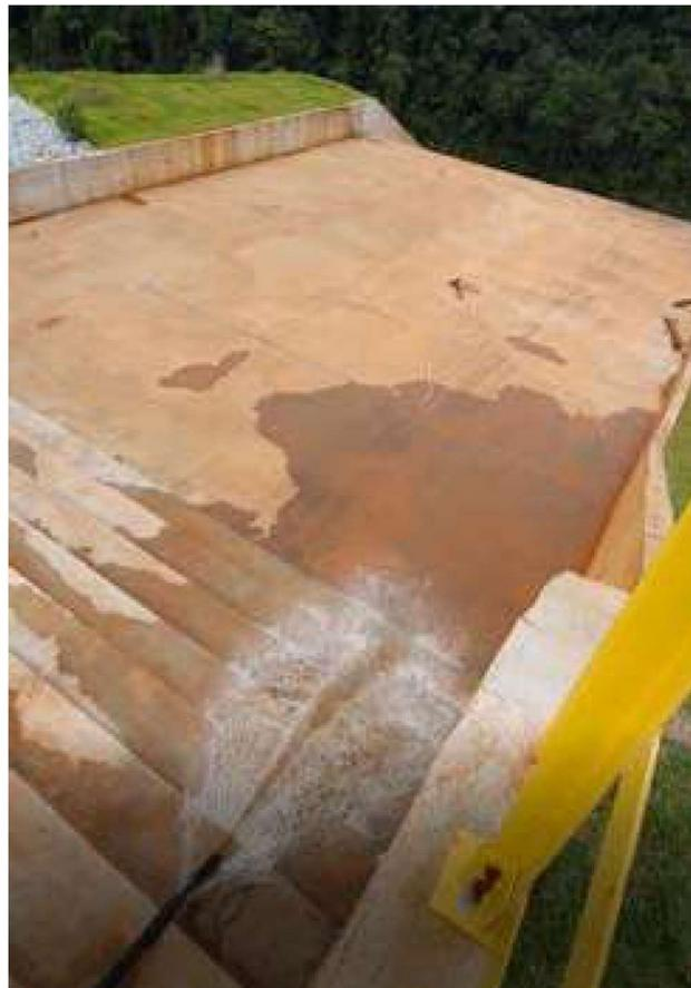
Figura 5 - Foto do dia 13 de janeiro de 2022 registro do momento de acionamento do sistema emergencial de bombeamento utilizado para auxiliar no esvaziamento da ECJ<sup>10</sup> - Acervo pessoal da Autora.
